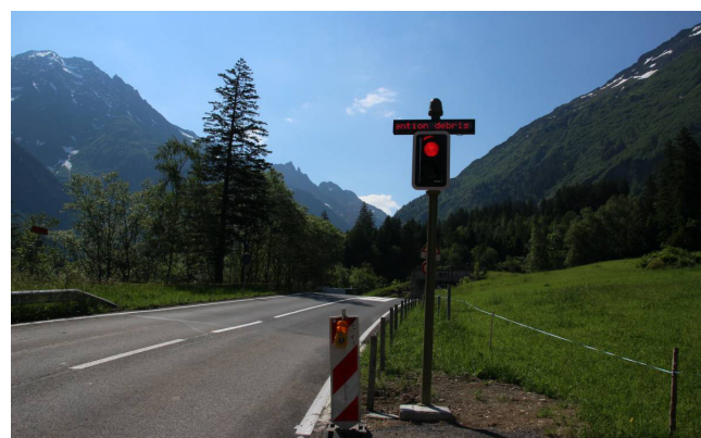
Figure 3 : Système d'alarme pour laves torrentielles: le texte défilant permet d'informer les usagers de la route bloquée aux feux.
