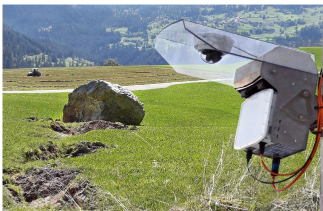
Figure 2 : Le radar de chutes de pierres détecte des blocs de rocher en mouvement et active automatiquement une caméra de surveillance, qui enregistre des images de l'événement.
