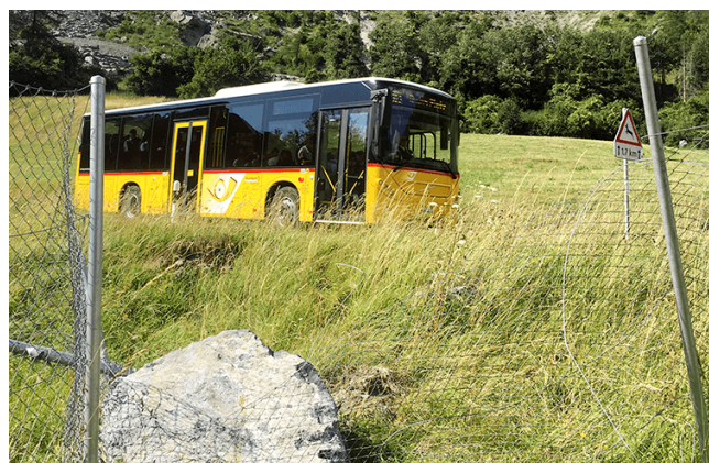
Figure 3 : La fermeture de route automatique du tronçon menacé augmente la sécurité des usagers de la route.
