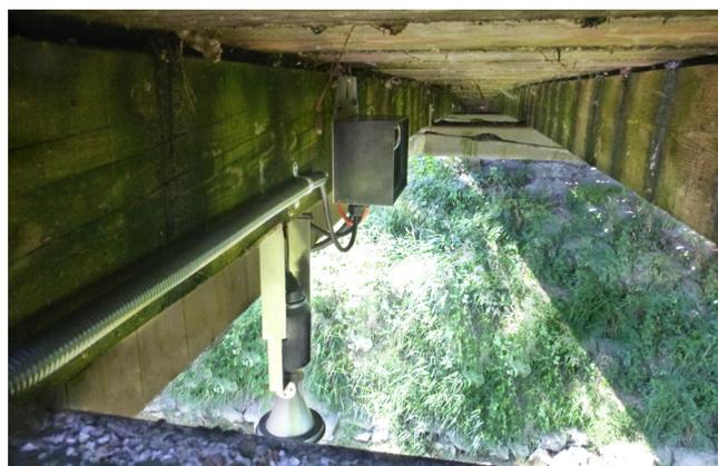
Abbildung 3: Ein Pegelradar, das unter einer Fußgängerbrücke montiert ist.
